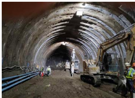
上曾トンネル内部の様子
